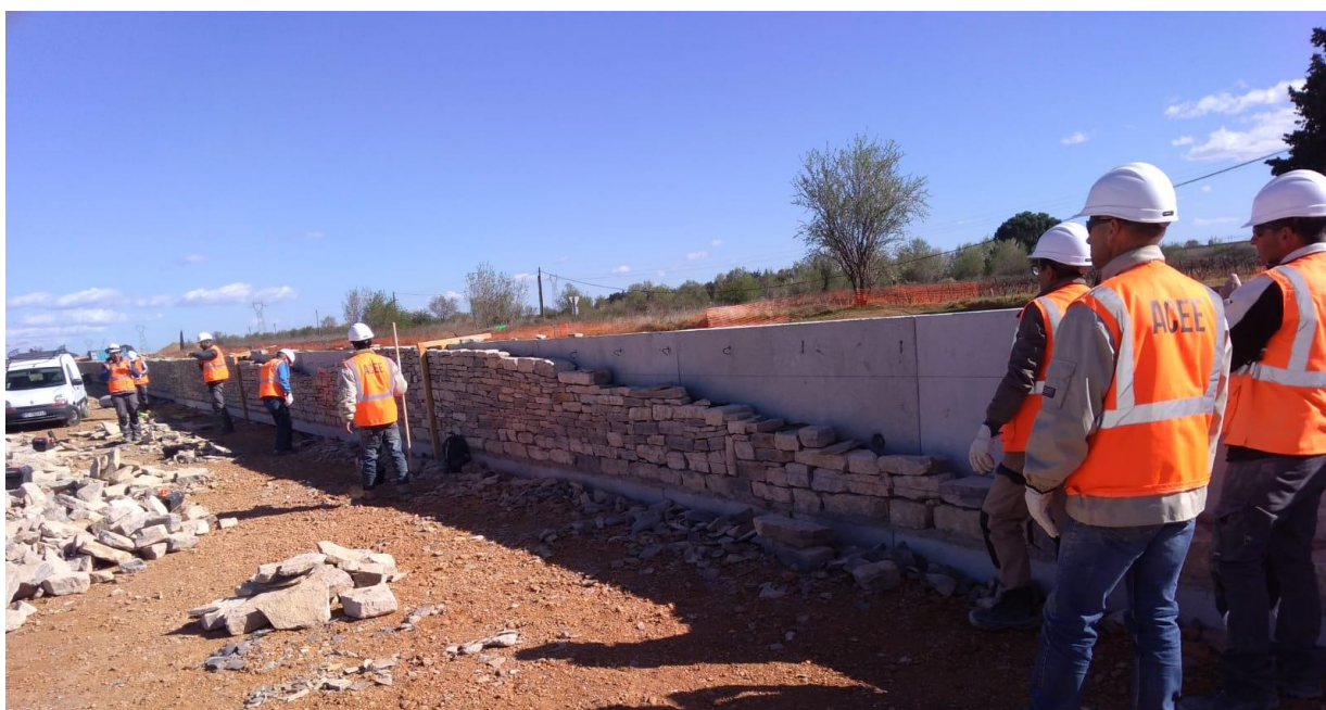
Chantier d'insertion – Création d'un mur en pierre sèche
