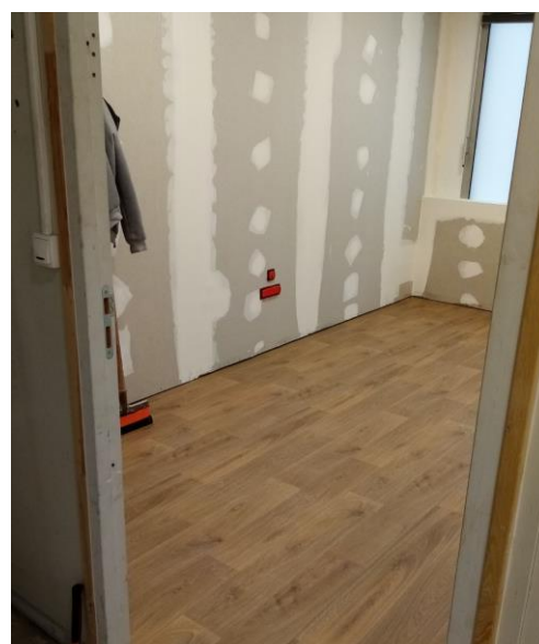
Ancienne salle CIUVP après travaux
