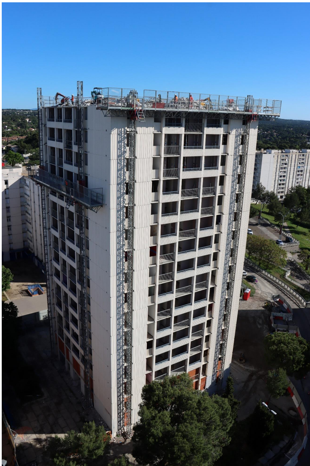
Démolition d'Avogadro sur Valdegour - Habitat du Gard
