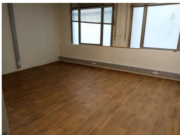
Ancienne salle CIUVP avant travaux
