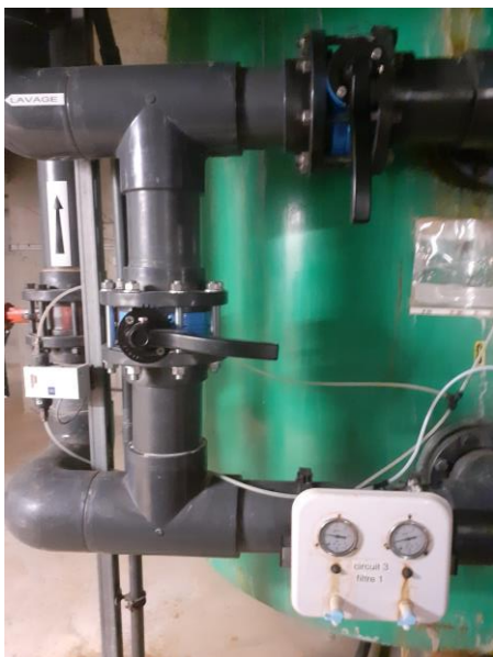
Remplacement des vannes Nemausa
